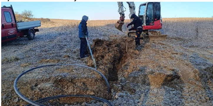
Výstavba elektrickej siete
